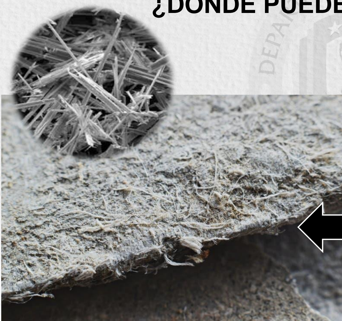
Tejas con fibras de asbesto
